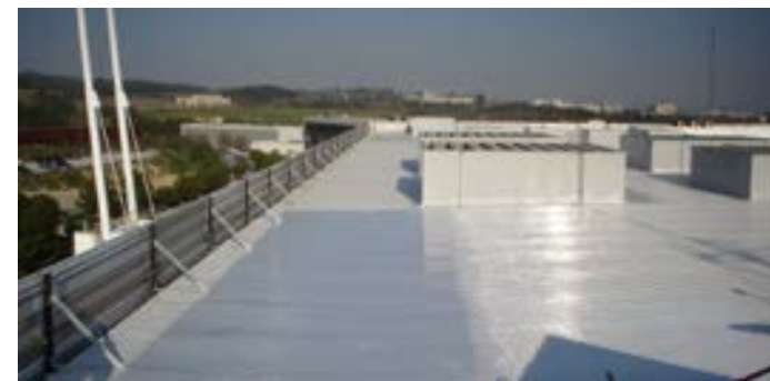
CUBIERTA EDIFICIO INDUSTRIAL - FRANCIA
